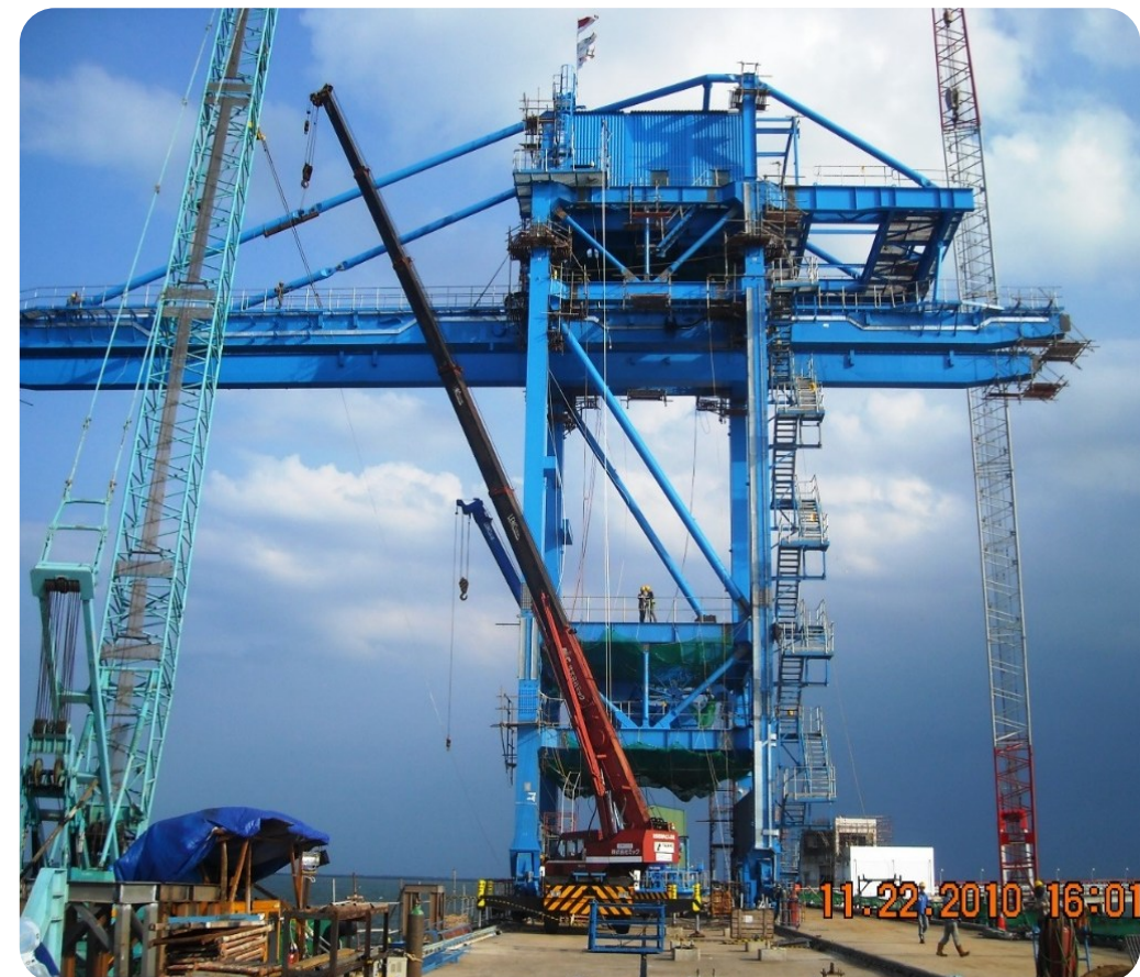
Title : GTSU Erection Year : Nov 2010
