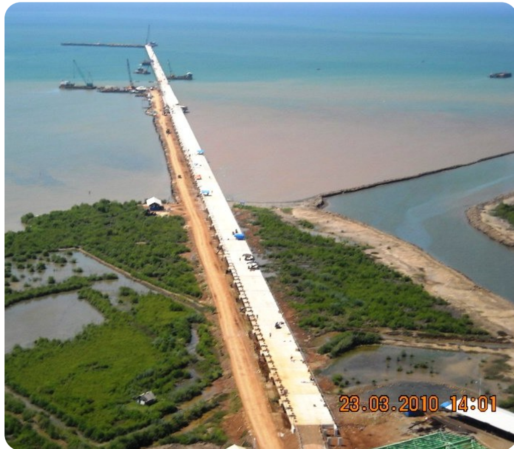
Title : Jetty + Trestle Year : March 2010
