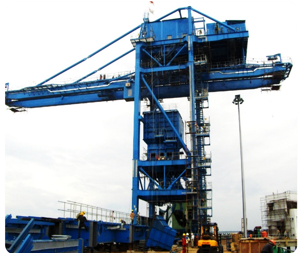
Title : GTSU Erection Year : Nov 2010
