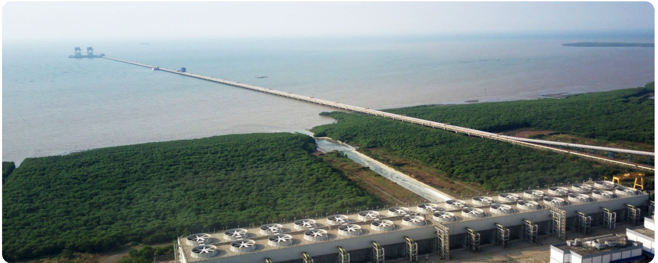
Title : Trestle of Jetty
