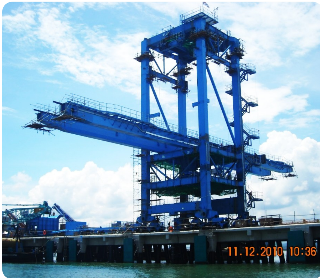
Title : GTSU Erection Year : Nov 2010
