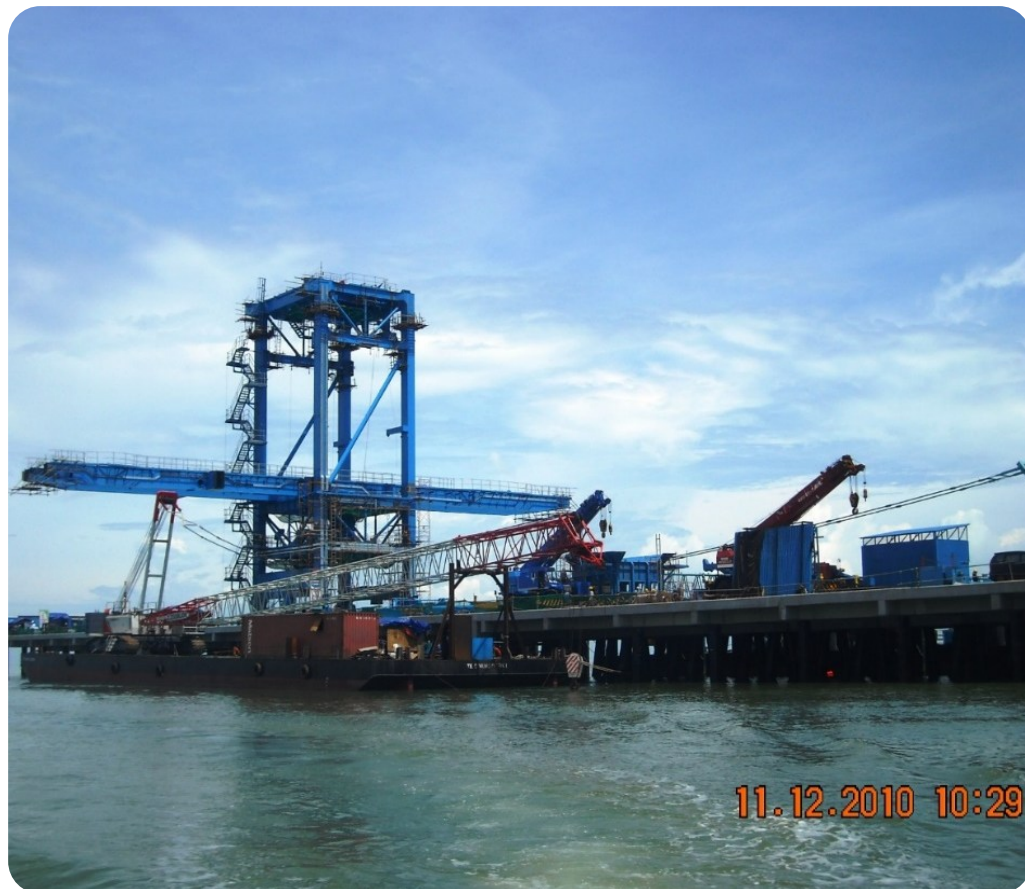
Title : GTSU Erection Year : Nov 2010
